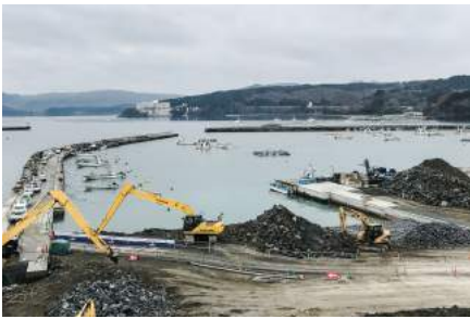
復興工事が続く志津川湾(2018年11月)
