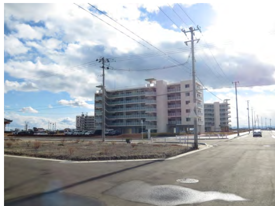
（写真 居住区域の災害公営住宅）
