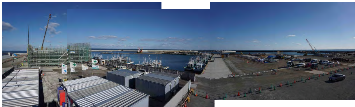
(写真 漁港内展望台から見た全景)
