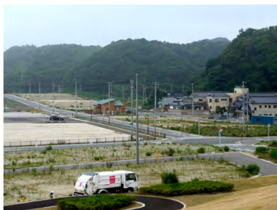
(写真 低地部の区画と残存住宅)
