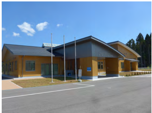
（写真 新築されたコミュニティセンター）
