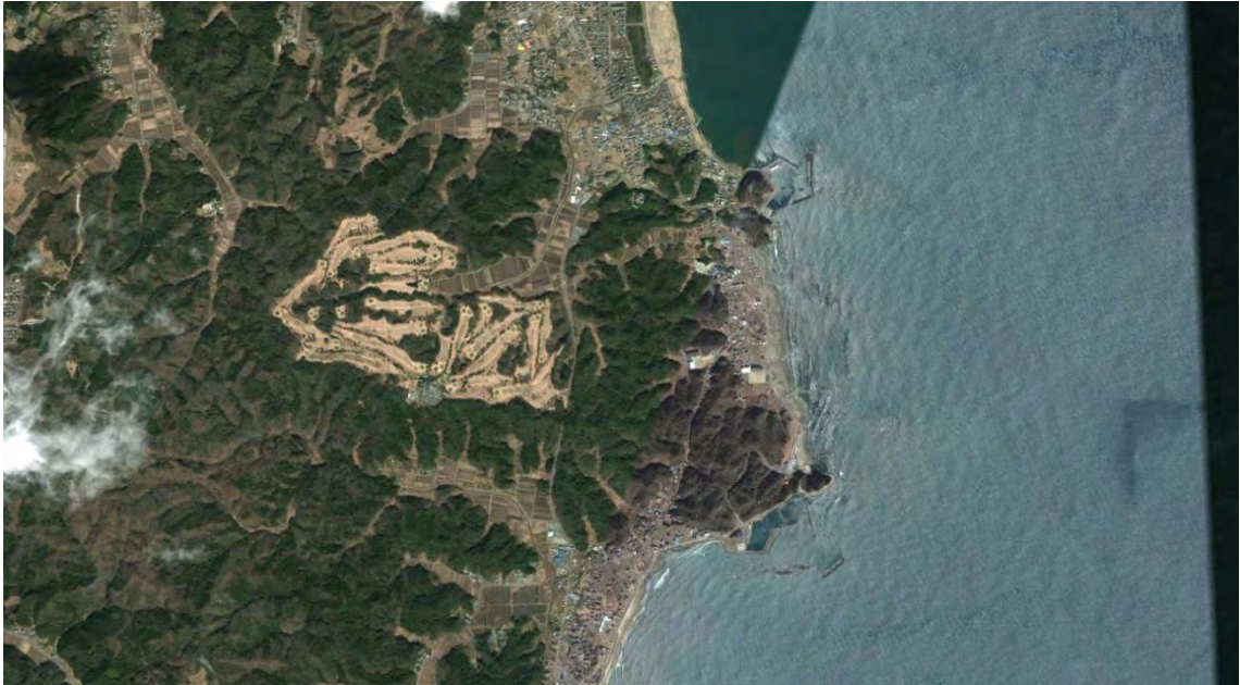
写真 震災直後の薄磯地区 (2011. 3. 12)
