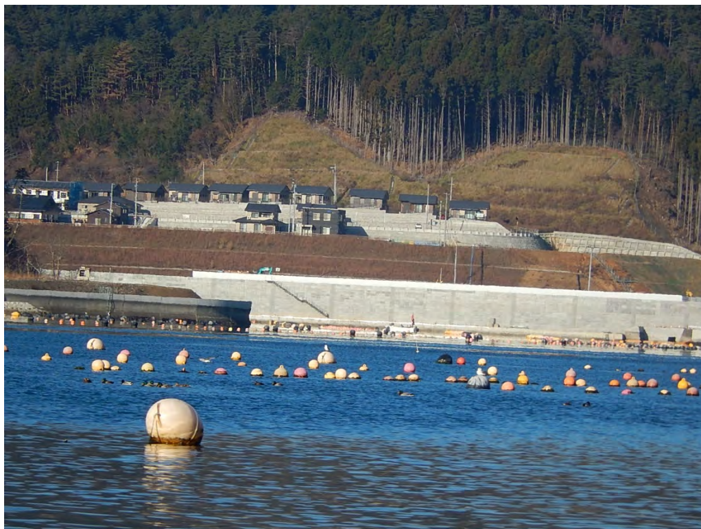
(写真：代表的防集高台移転地の開発状況)
