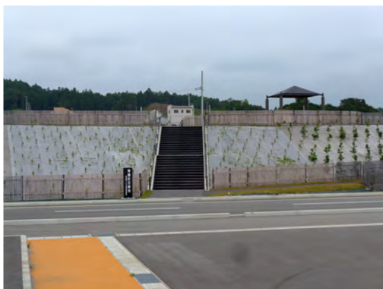
(写真 海岸堤防から防災緑地を望む)
