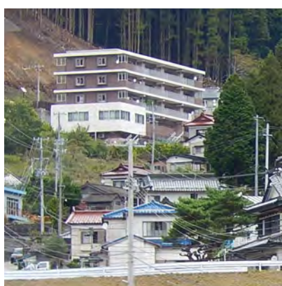
写真： 高台に建設され た災害公営住宅
