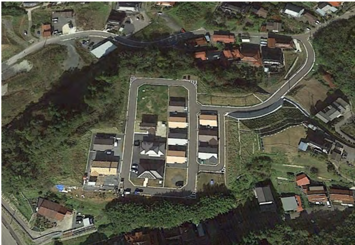
(写真：完成した防集団地)
