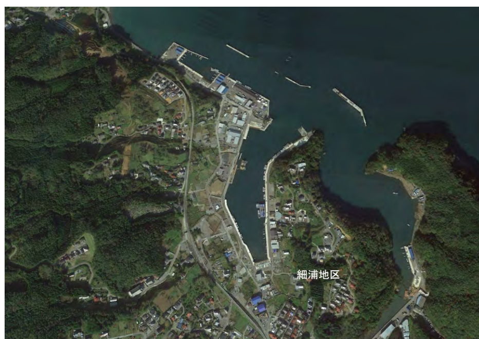
(写真：震災後の細浦地区／2017. 10. 24)
