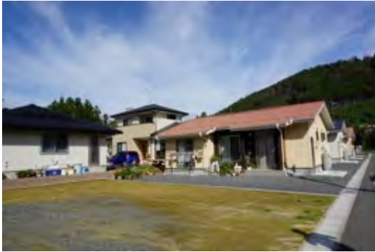
(写真：完成した防集団地)
