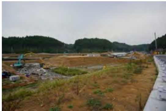
（写真：整備中の国道及び河川堤防）
