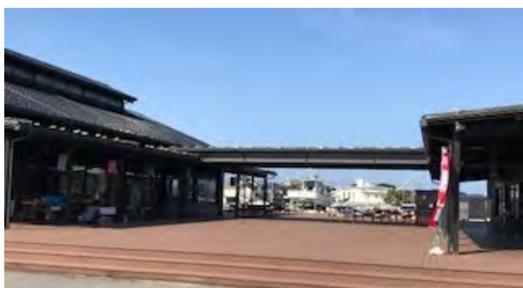
魚の駅「生地」の外観。左右に振り分けられて建ち、港が見通せる
