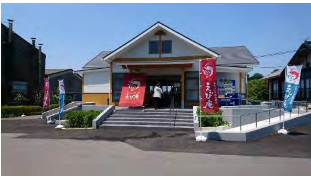
えび庵外観（既存の観光案内所施設を改築）
