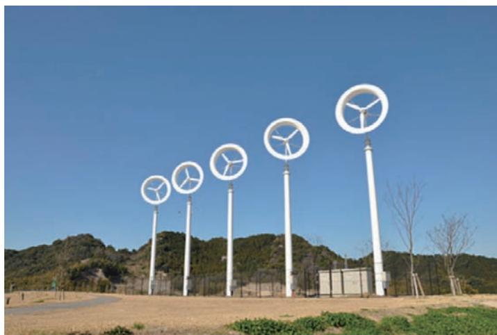
現在九州大学伊都キャンパスに設置されている「風レンズ風車」。高さは13.4メートル、風車本体の直径は3.4メートル、定格出力は5キロワット
