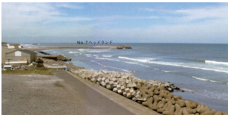
2003年 漂砂防止のためヘッドランドが設置され砂浜が分断される (1987年着工、2001年完成)
