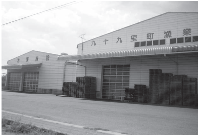
写真2 九十九里町漁協の冷凍関連施設
