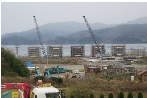
写真 3-9： 米崎地区の防潮堤工事。 住民の反対で着工が遅れた
