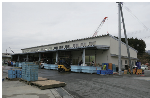
写真 3-8： 米崎の漁港のカキなどの 加工処理施設
