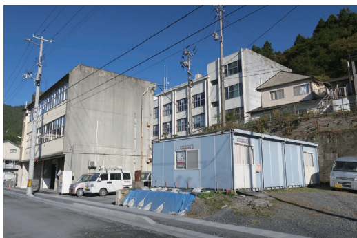
写真 2-1： 釜援隊のマネジメント協議会の 事務所（手前のプレハブ平屋）
