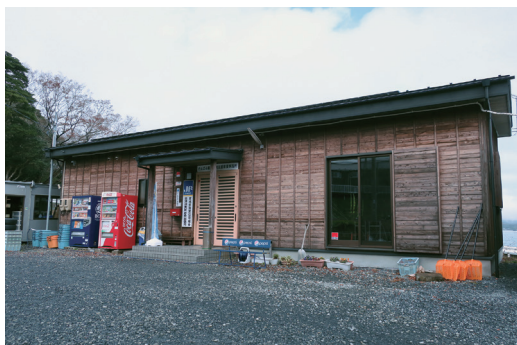
写真 5-8： 戸倉出張所の建物
