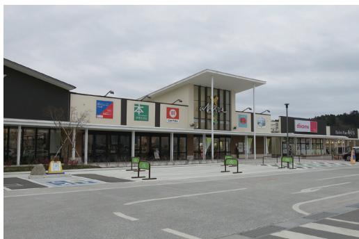
写真 3-5 : 17 年 4 月、かさ上げ地区の中心地に完成した大型複合商業施設「アバッセたかた」
