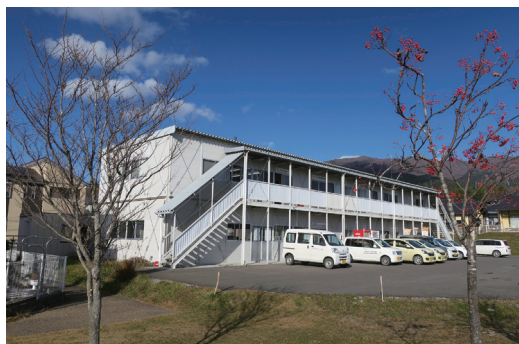
写真 3-3 : マルゴト陸前高田の事務所が 入る建物
