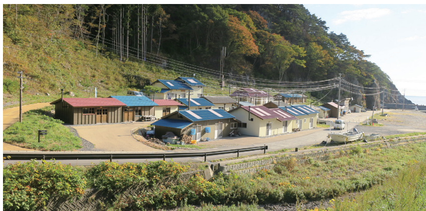
写真 1-5 : 再建された机浜番屋群。右手奥が海
