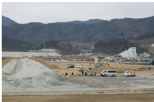
写真 3-4 : 防潮堤と大規模なかさ上げ工事は 20 年度末に完了予定
