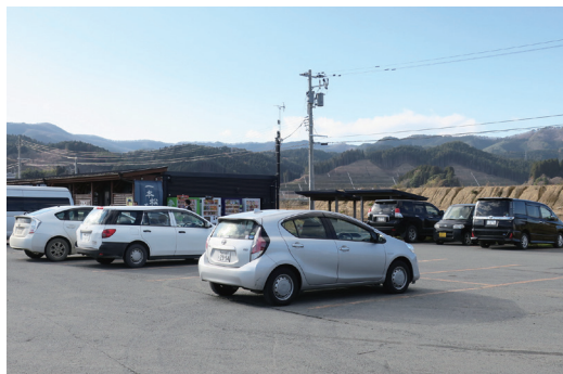
写真 3-1 : 一本松茶屋と駐車場。かさ上げ 工事の盛土が迫る (18年12月撮影)
