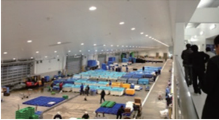
図3 閉鎖型荷さばき所（愛媛県八幡浜漁港）
