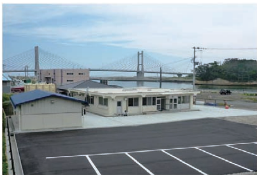
写真10 復旧した水産試験場相馬支場
