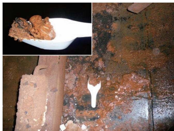
図31 バラストタンク内に堆積した泥
