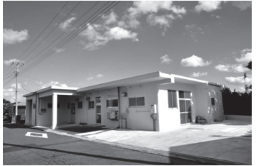
写真 11 新加工場外観（空き住宅内部を改修）
