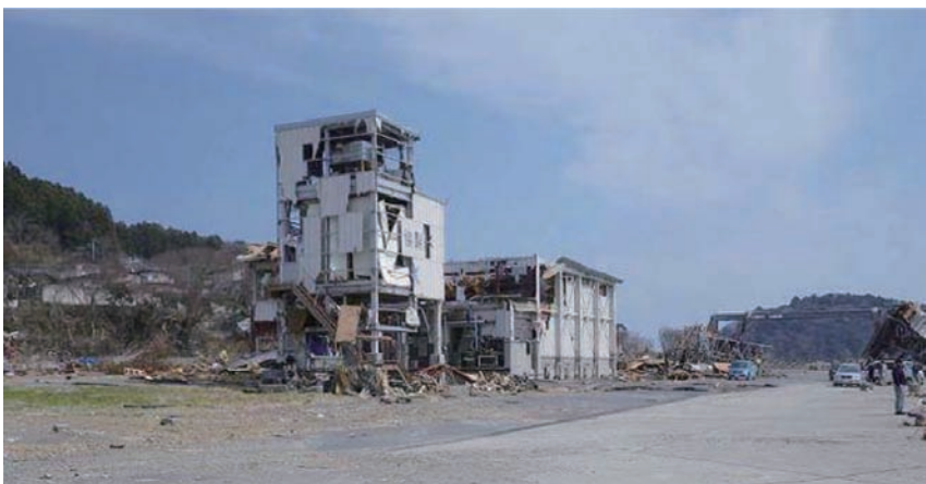
手前から、被災した製氷施設、冷蔵庫及び水産加工場（宮城県南三陸町）
