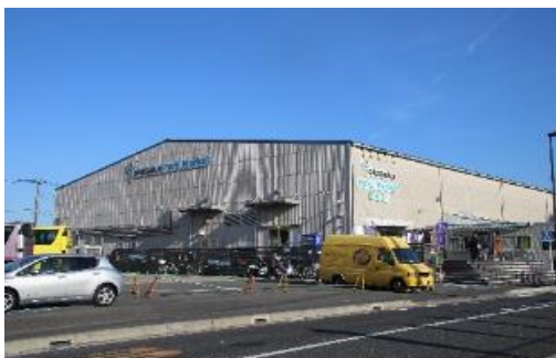
施設は旧マグロ冷凍倉庫を買い取って改修した。
