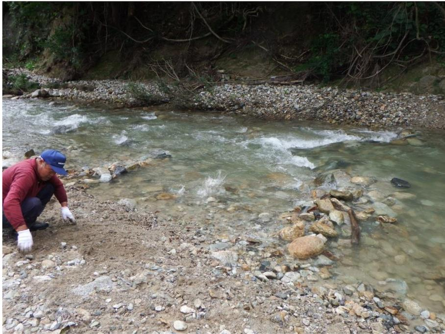
写真7 巨礫を水制の様に積み上げる
