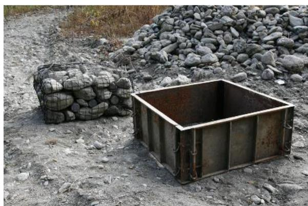
図3 製作用枠と作成された石倉（神流川）
