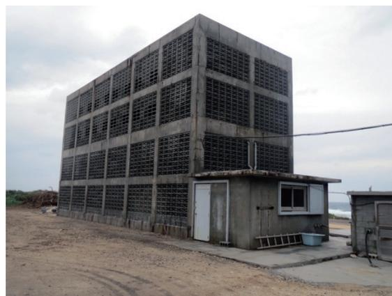
タワー方式の製塩工場（沖縄県・粟国島）
