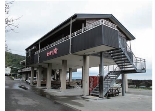
2007年に、国の補助のほか自己資金1千万円を投じて建てた交流施設。調理室と、食事や室内プログラムができる広間を備える
